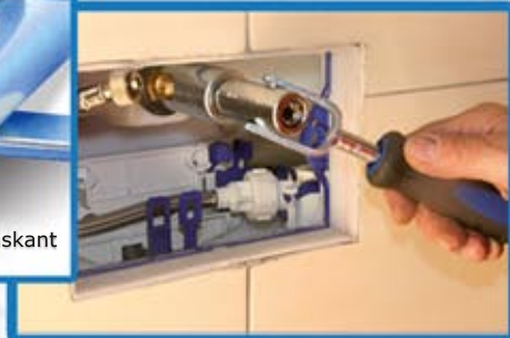
Ein- und Ausschrauben von Eckventilen
